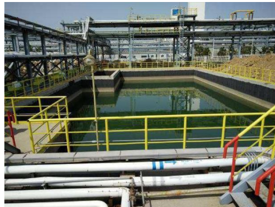
装置区初期雨水池
