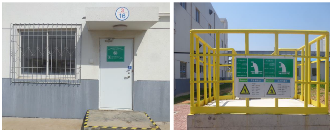
图 15.3-2 依托的万华环保科技有限公司现有排污口及在线监测小屋
