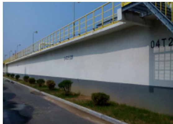
依托的污水处理站事故水池
